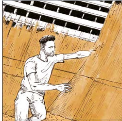
PAR RANGÉES SUCCESSIVES, LES BOTTES SONT POSÉES SUR LE TOIT. LES TIGES DE ROSEAU SONT ÉTALÉES, FAÇONNÉES ET SERRÉES SOUS DES BARRES HORIZONTALES EN ACIER GALVANISÉ.
