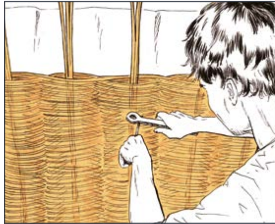
LES BRINS D'OSIER SONT TISSÉS SUR LES MONTANTS EN SUIVANT LE GABARIT DE LA VOÛTE.
