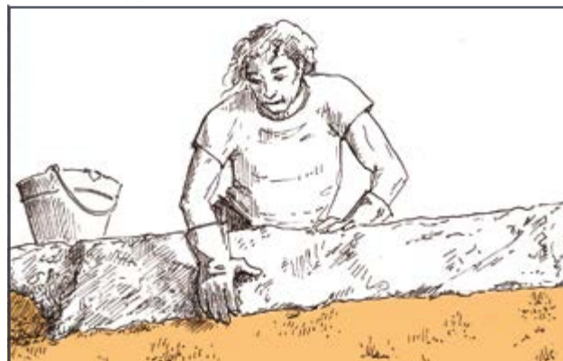
LE FAÏTAGE EST RÉALISÉ À LA CHAUX.
