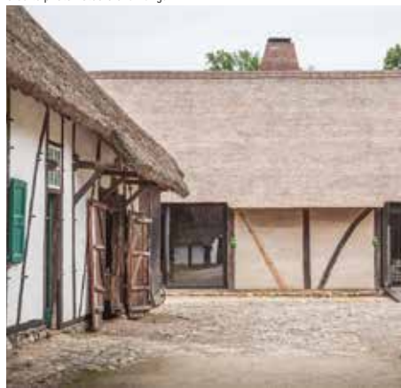
Reconversion d'une grange en boulangerie, Belgique crédits photo : Thomas Noceto
