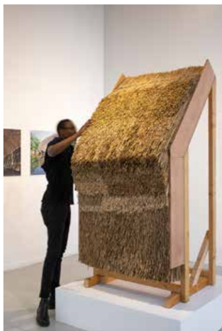
Prototype de bardage et couverture en chaume crédits photo : Pierre l'Excellent
